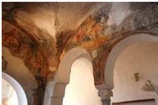
La caratteristica costruttiva delle architetture è data dai materiali che, ad eccezione dei marmi come colonne, capitelli, lastre, realizza una muratura in semplice pietrisco di roccia e malta ricoperta da intonaco.
