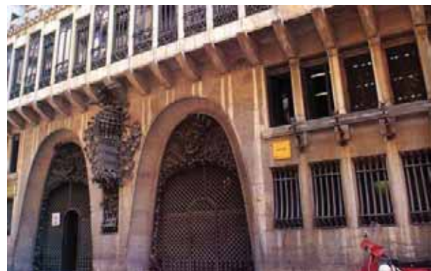
4. Barcellona. Palau Güell (1886-89). Facciata principale. Particolare degli archi per l'entrata e l'uscita delle carrozze.
