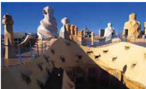
22. Barcellona. Casa Milà. Particolare della terrazza di copertura con i camini e i vani scale.
