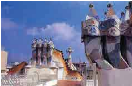
18. Barcellona. Casa Batlló. I camini al piano di copertura.
