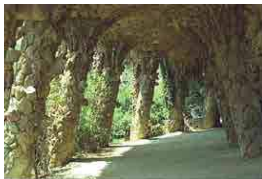
14. Barcellona. Park Güell. Interno di un portico.
